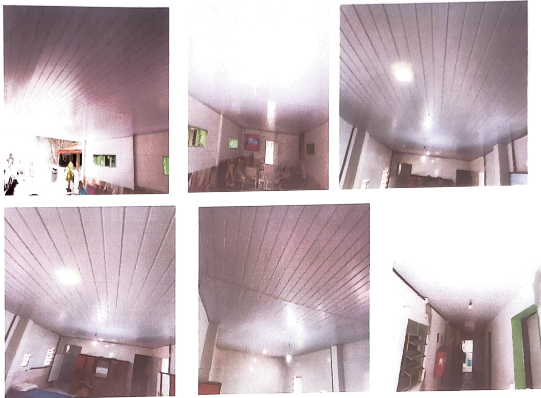
ADEQUAÇÃO DA ESTRUTURA FÍSICA COM INSTALAÇÃO DE FORRO DE PVC
